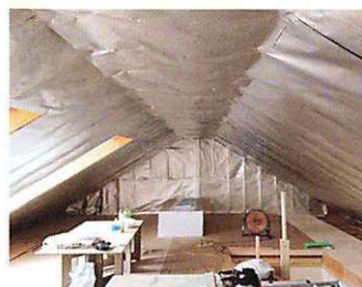
木造の小屋裏部屋へ!
