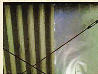
屋根下遮熱 左側なし 右側施工あり
